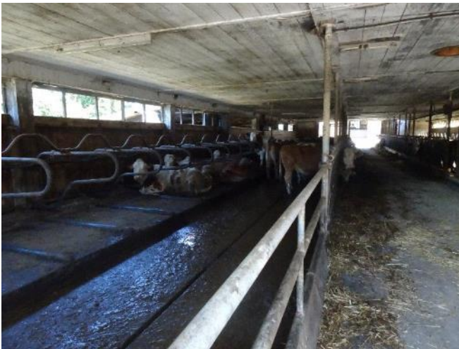
Foto 7: 1c - Alter Viehstall mit zahlreichen Schwalbennestern (Innenansicht)
