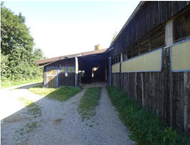
Foto 5: 1c - Alter Viehstall mit Holzverkleidung (Westseite)
