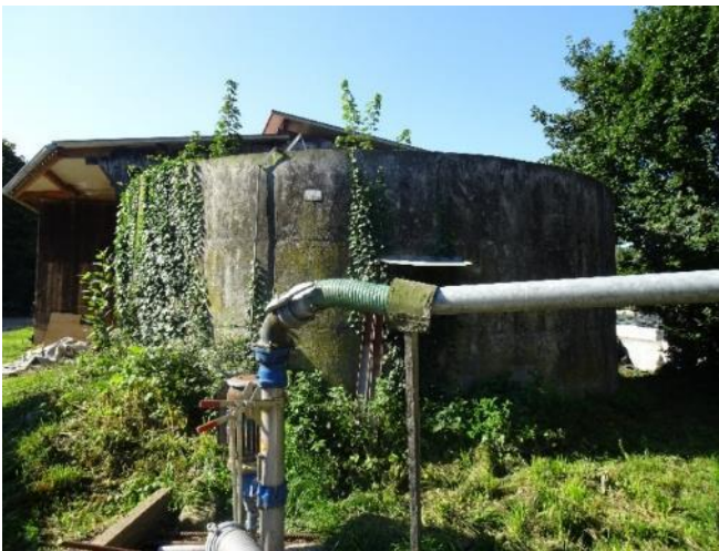
Foto 31: 14 – Altes Silo inmitten des Hofgeländes mit Efeubewuchs
