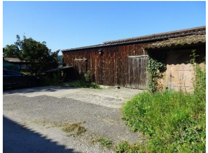
Foto 6: 1c - Alter Viehstall mit Holzverkleidung (Ostseite)
