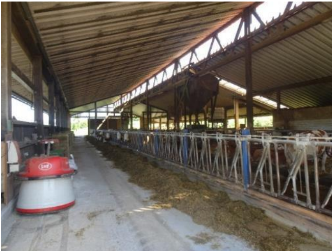
Foto 3: 1b - Neuer Rinderstall im Norden des Plangebietes (Innenansicht)
