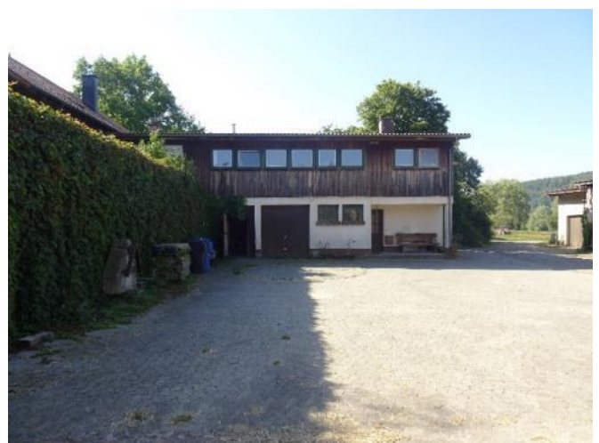
Foto 10: 1e - Anbau vom Wohnhaus
