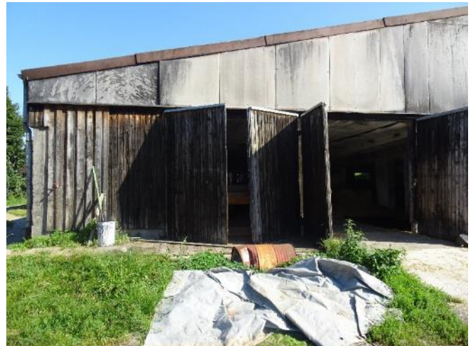
Foto 4: 1c - Alter Viehstall mit Holzverkleidung und Dachverwahrung (Südansicht)
