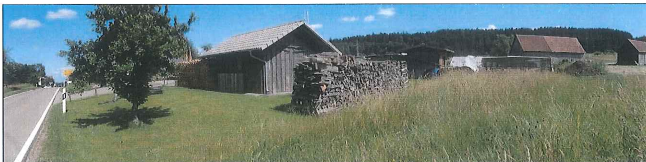
Ansicht auf den Schuppen mit Außenanlagen auf Grundstück Nr. 1155. Rechts im Bild FFH-Mähwiese, die gemäß Luftbild bis hinter den Holzstapel reichen würde.
