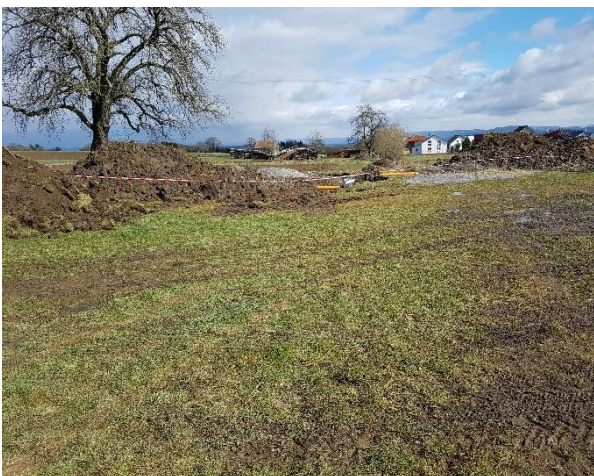
Rohbodenfläche/Baustelle südlich innerhalb des Plangebiets. Blickrichtung Nordosten.
