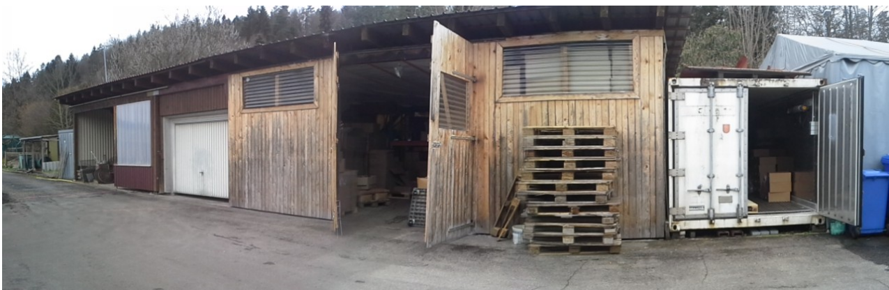
Abb. 8: Gebäude Nr. 2 aus östlicher Richtung betrachtet.
