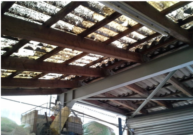
Abb. 19: Offen zugänglicher Dachbereich von Gebäude Nr. 3, jedoch mit Störungen durch den Betriebsablauf
