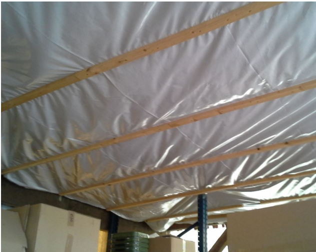
Abb. 16: Mit Plane bespannter Dachbereich von Gebäude Nr. 2
