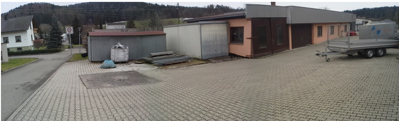
Abb. 7: Gebäude Nr. 1 mit Garage, aus nördlicher Richtung betrachtet
