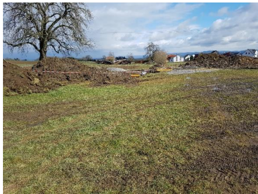
Foto 5: Rohbodenfläche/Baustelle südlich innerhalb des Plangebiets. Blickrichtung Nordosten.
