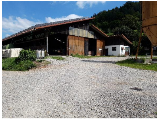
Foto 3: Hofgebäude, Blickrichtung Nordosten
